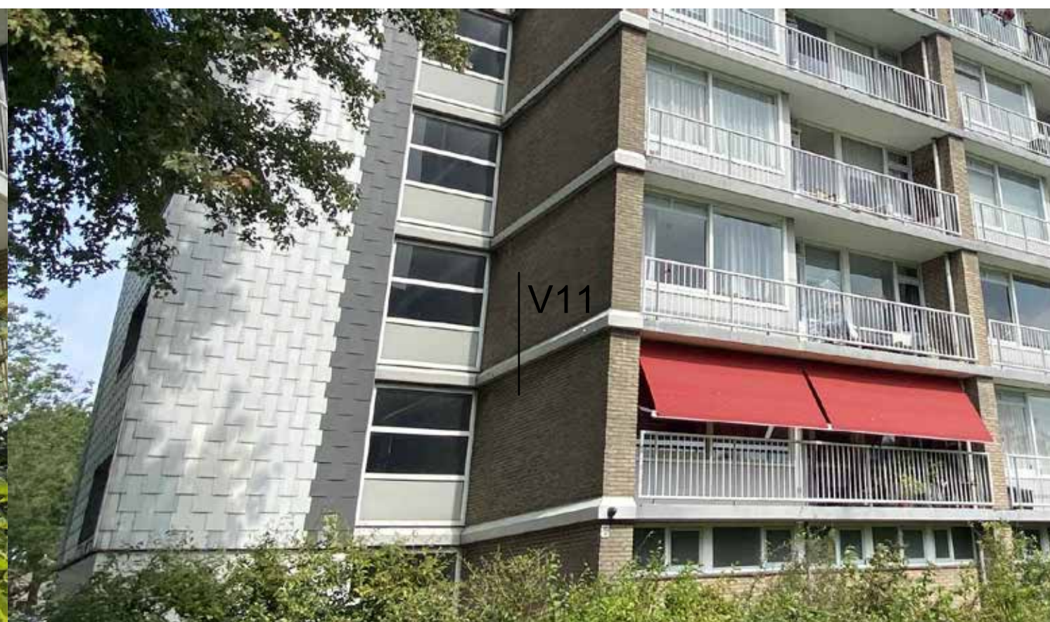
Huidige betonranden zuidgevel flat K
