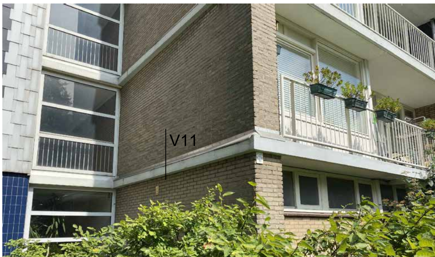
Huidige betonranden zuidgevel flat J
