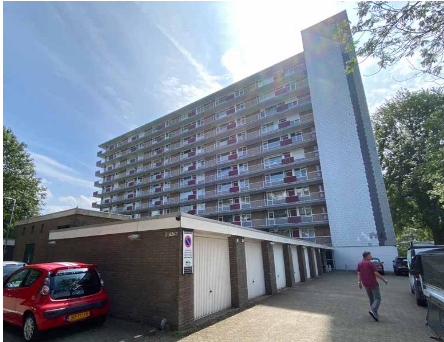
Noordgevel (flat K)
