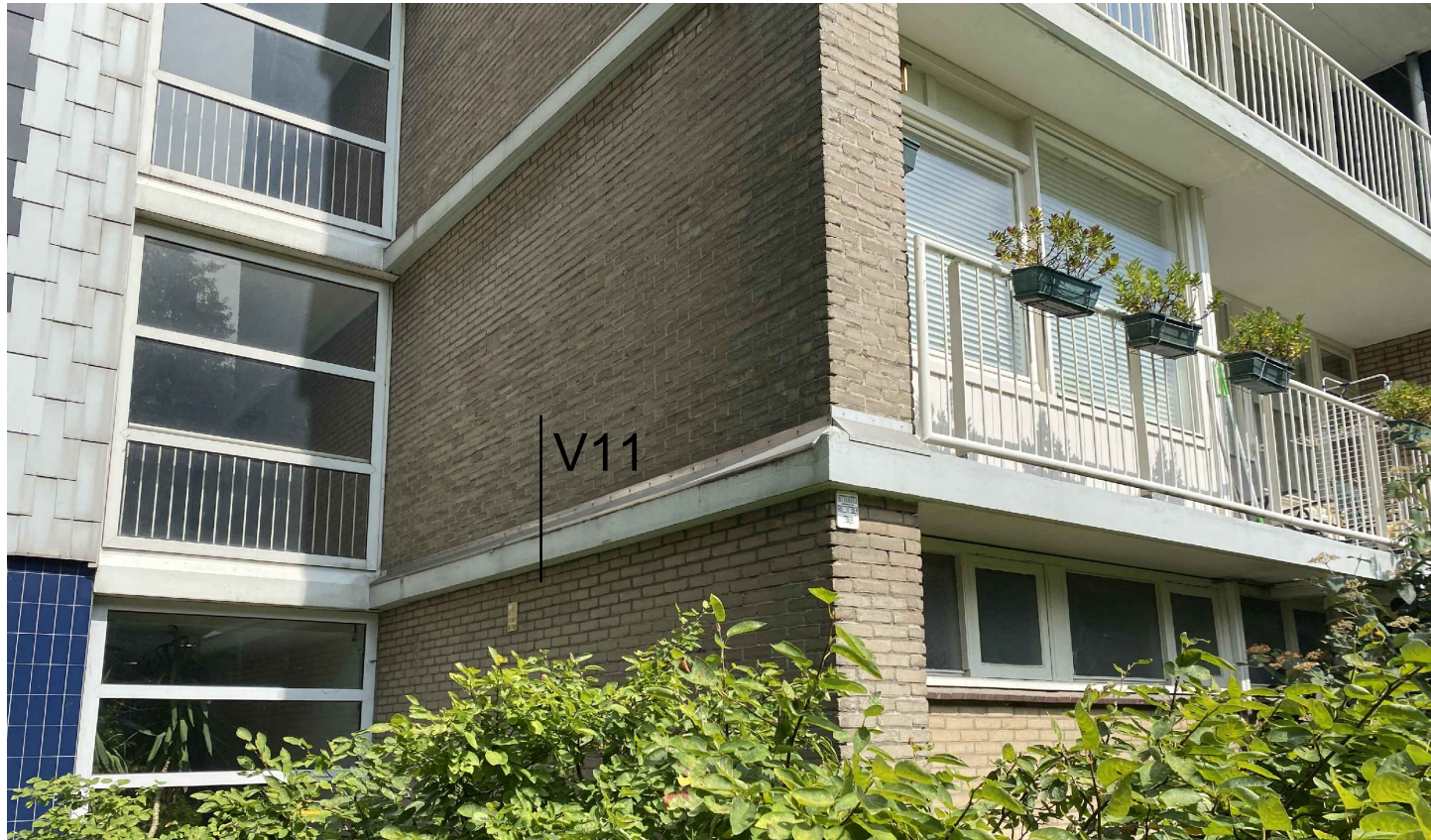
Huidige betonranden zuidgevel flat J
