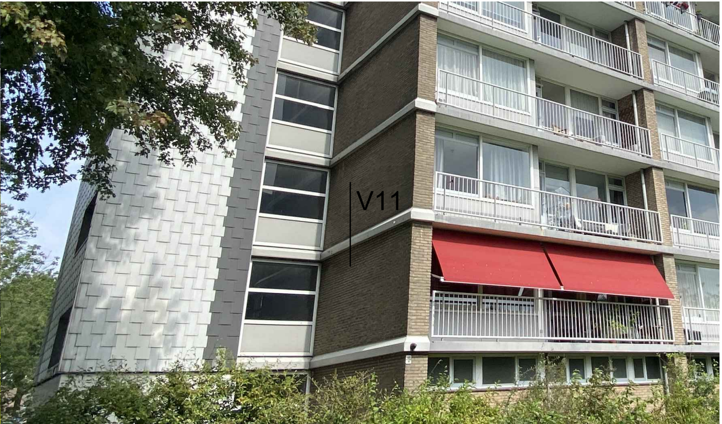
Huidige betonranden zuidgevel flat K
