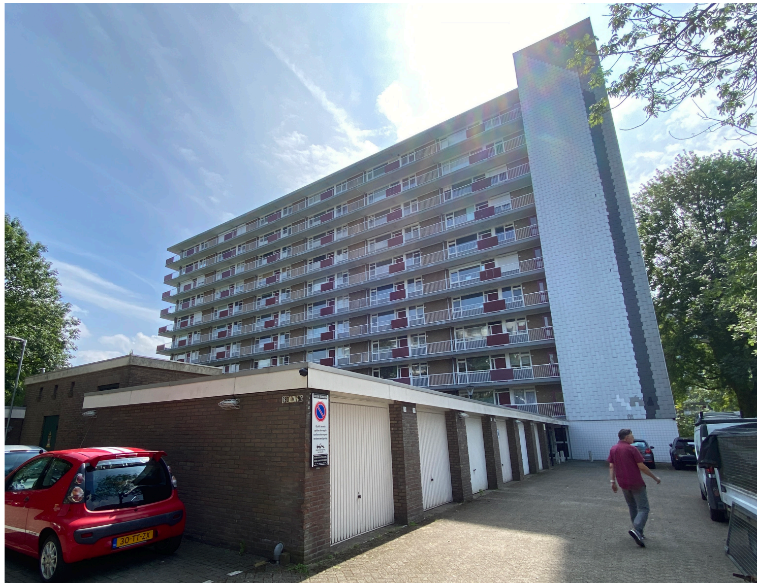
Noordgevel (flat K)
