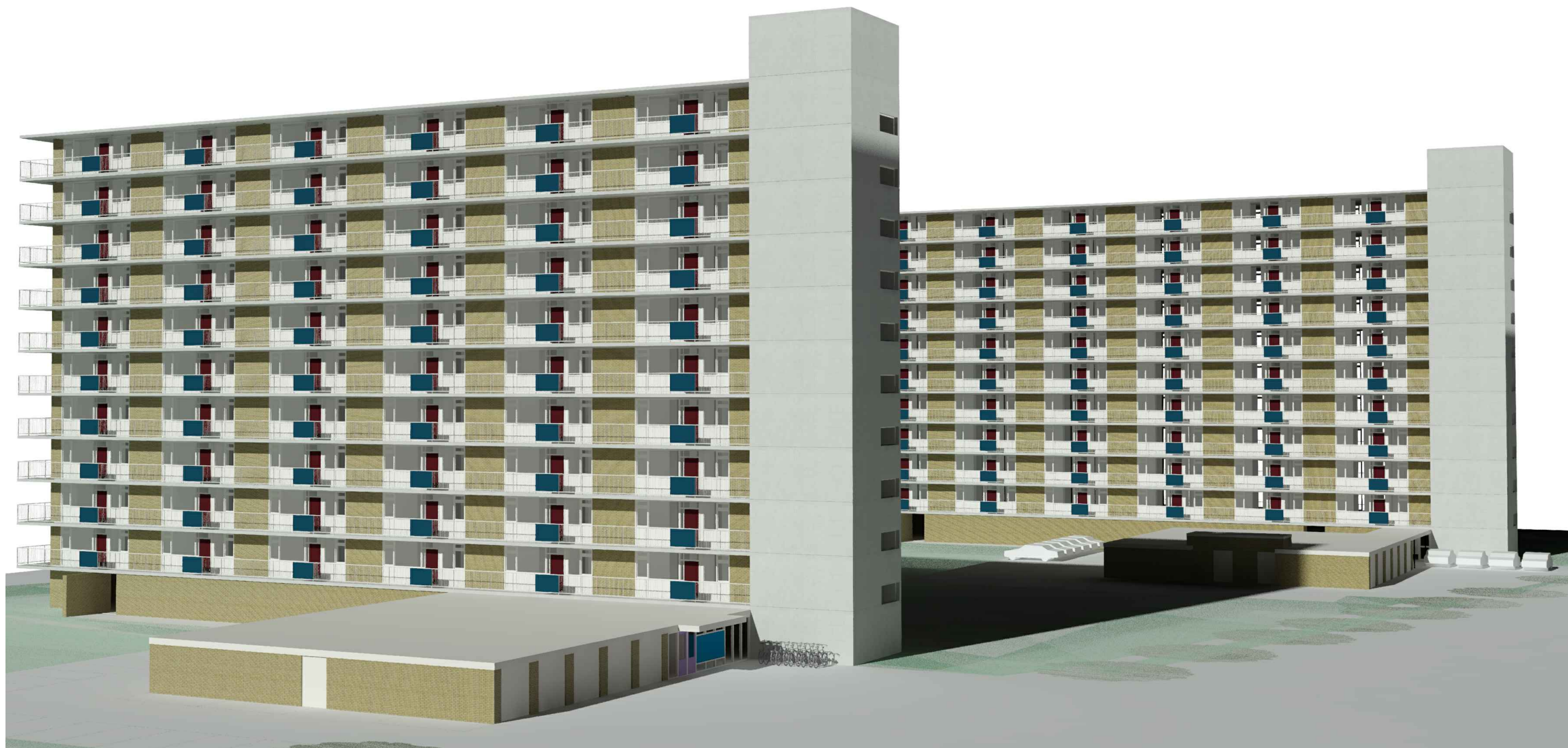
Noordgevels bestaand/nieuw (links flat J en rechts flat K)
